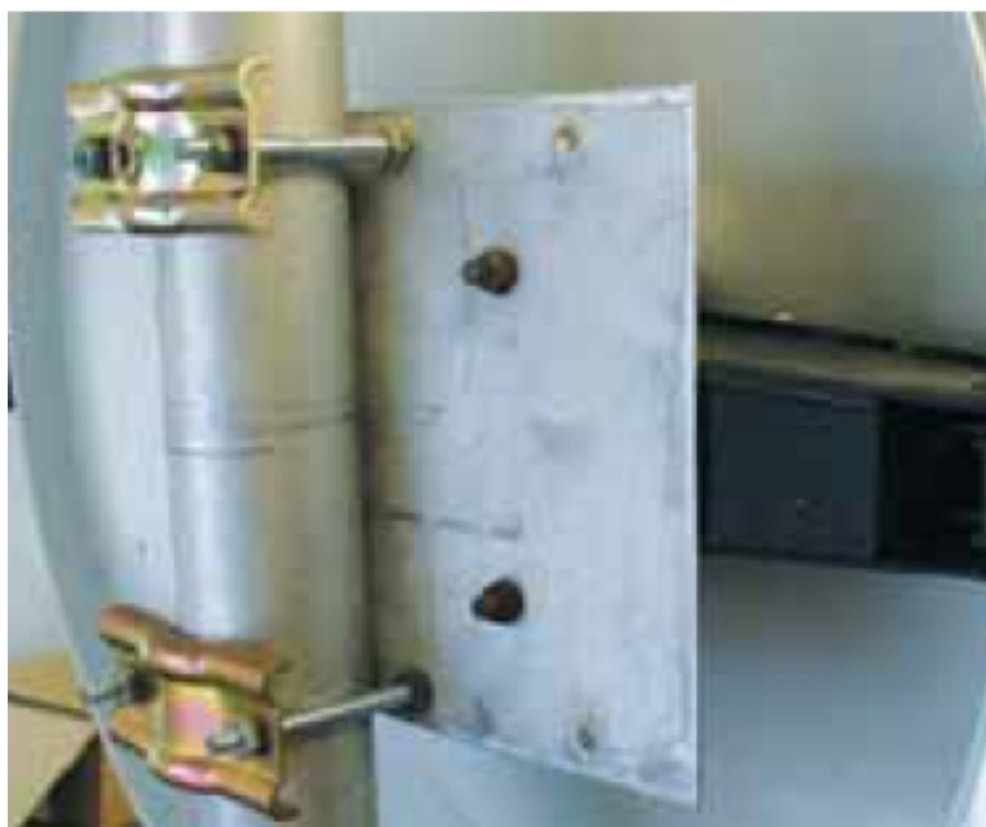
Fot. 3.9. Montaż czaszy przy użyciu dodatkowej płytki metalowej
